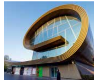
Die moderne Fassade des Teppichmuseums
